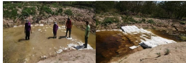
ฝายชะลอน้ำ บริเวณบ่อน้ำฝนแปลงสนับสนุนบริษัทเซฟรอน ประเทศไทย
